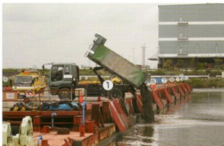
浮桟橋による埋立
