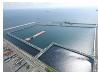
南本牧廃棄物最終処分場 （第5ブロック）
